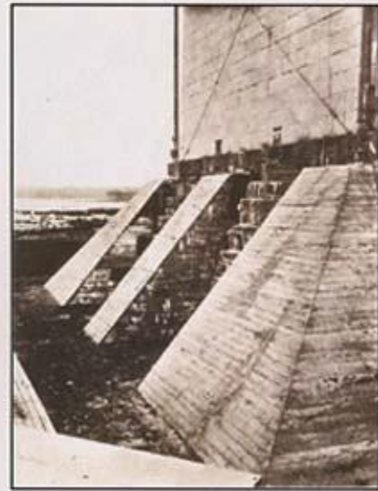
(d) South Buttresses
